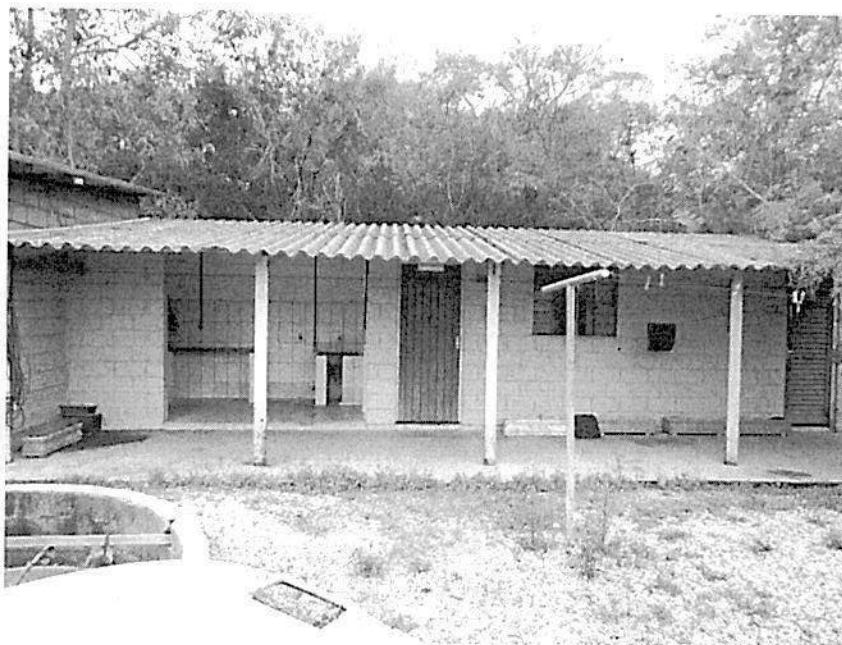
VISTA DO VESTIÁRIO PARA FUNCIONÁRIOS.
