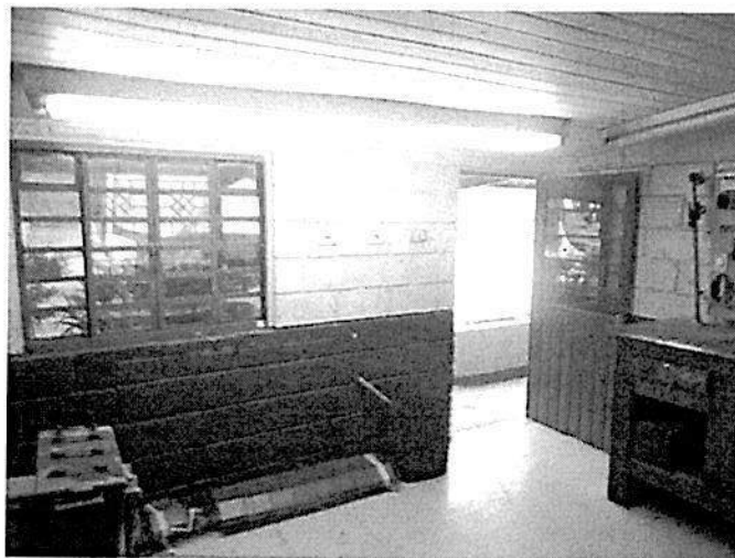
VISTA DA ÁREA DE CIRCULAÇÃO INTERNA.
