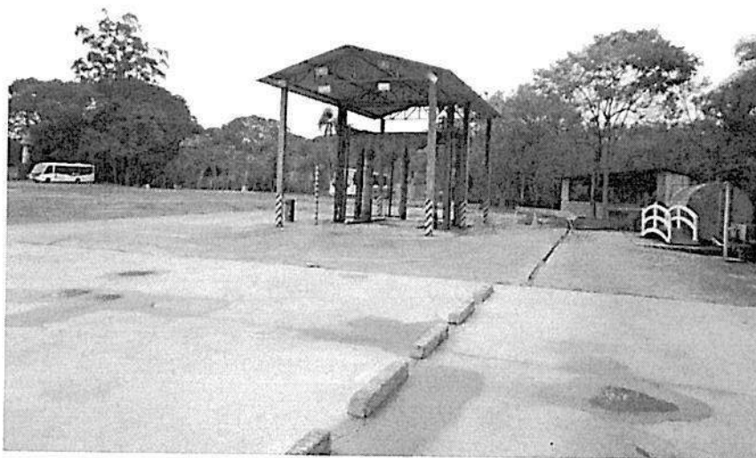
VISTA DA ÁREA DE LAVAGEM.
