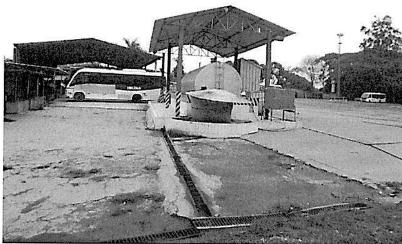
VISTA DAS BOMBAS DE COMBUSTÍVEL.
