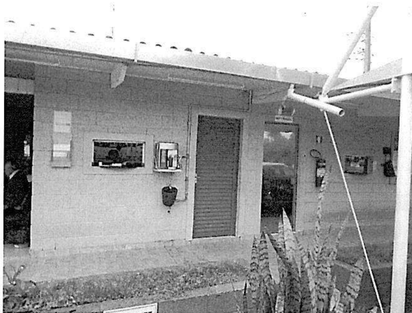
VISTA DA ÁREA DE CIRCULAÇÃO EXTERNA.
