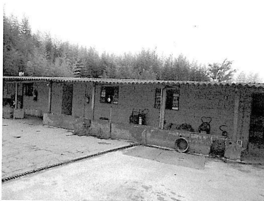
VISTA DA ÁREA AUXILIAR DE SERVIÇO.
