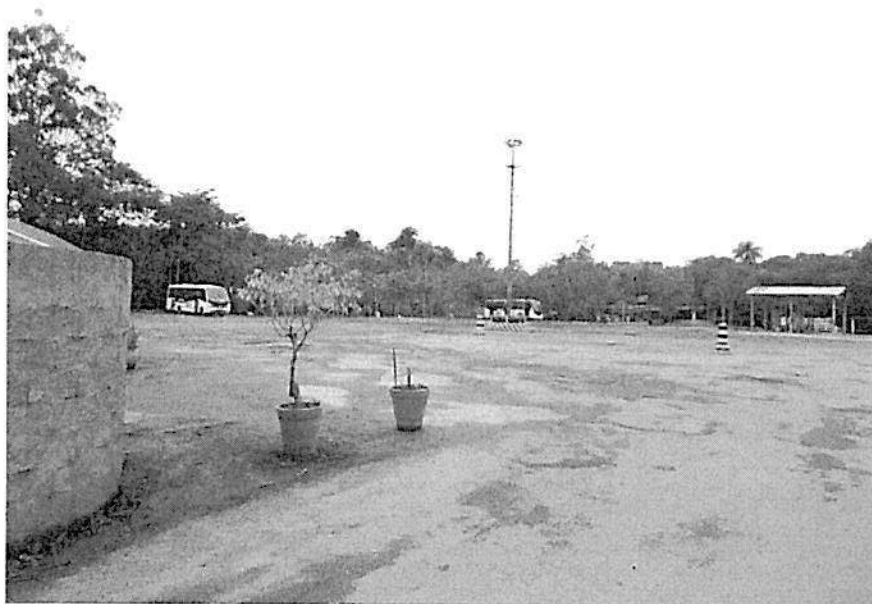
VISTA DO PÁTIO DE MANOBRA DE VEÍCULOS.
